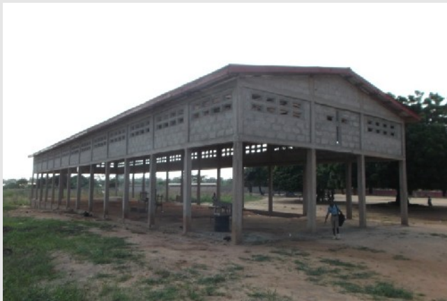
Le nuove aule scolastiche ad oggi
