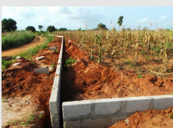
Particolare del muro di cinta
